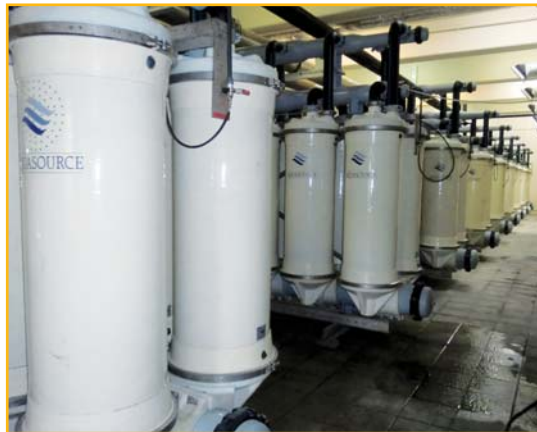
bloc filtration - usine de Vivé (Martinique)
